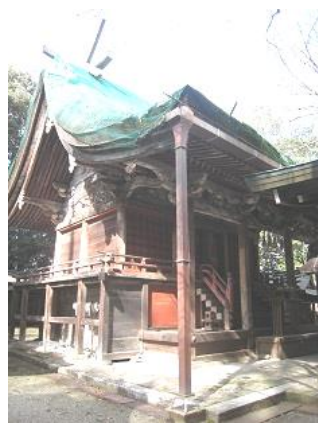
網で檜皮の崩れを防いでいます
